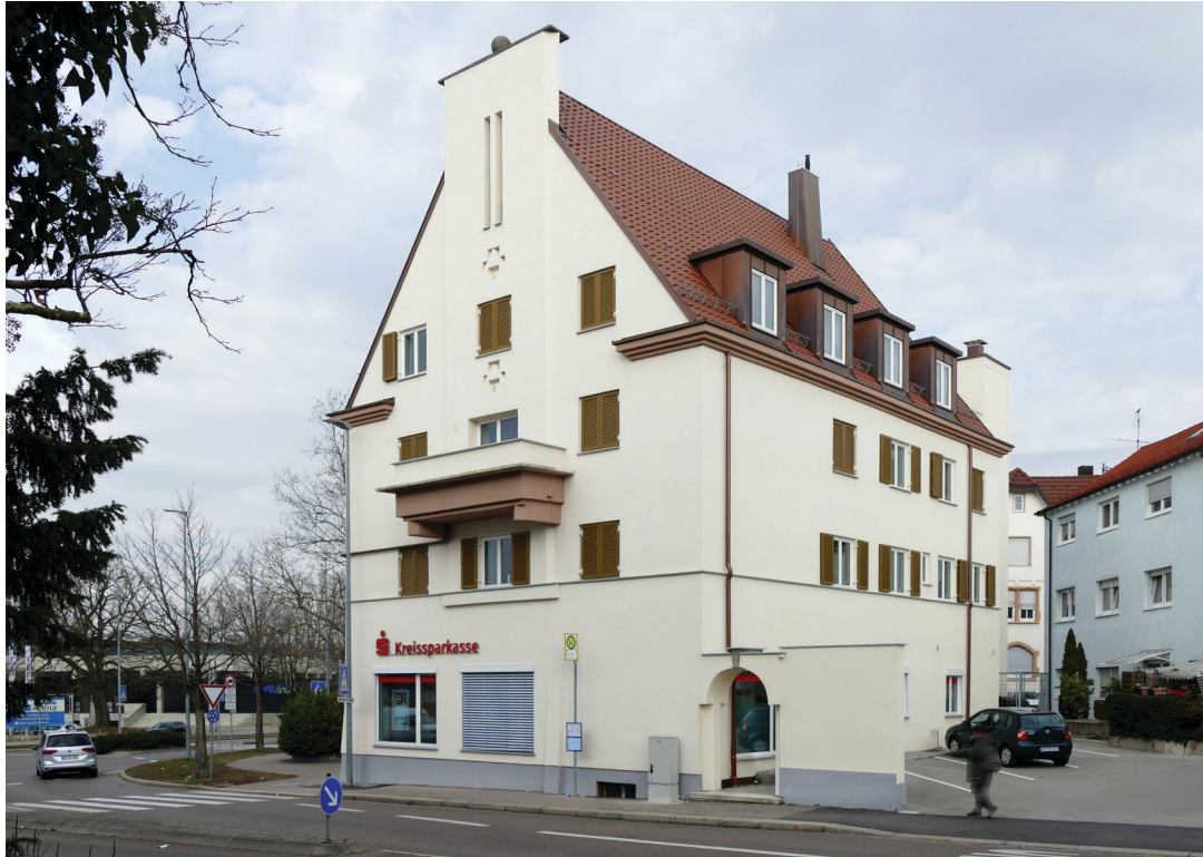
Neubau: südliche Ansicht in der Nördlichen Ringstraße
